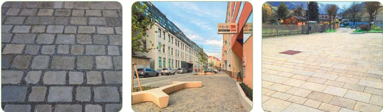
Abbildung 3: Betonstein mit aufgeweiteter Sickerfuge und kapillarbrechender Splittfüllung
