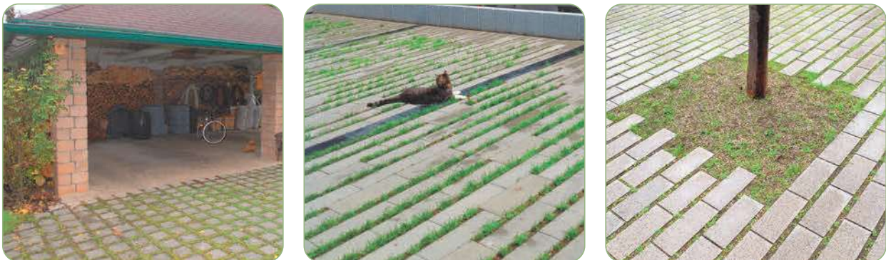
Abbildung 4: Betonstein mit aufgeweiteter Sickerfuge und kapillarer Grünfugenfüllung
