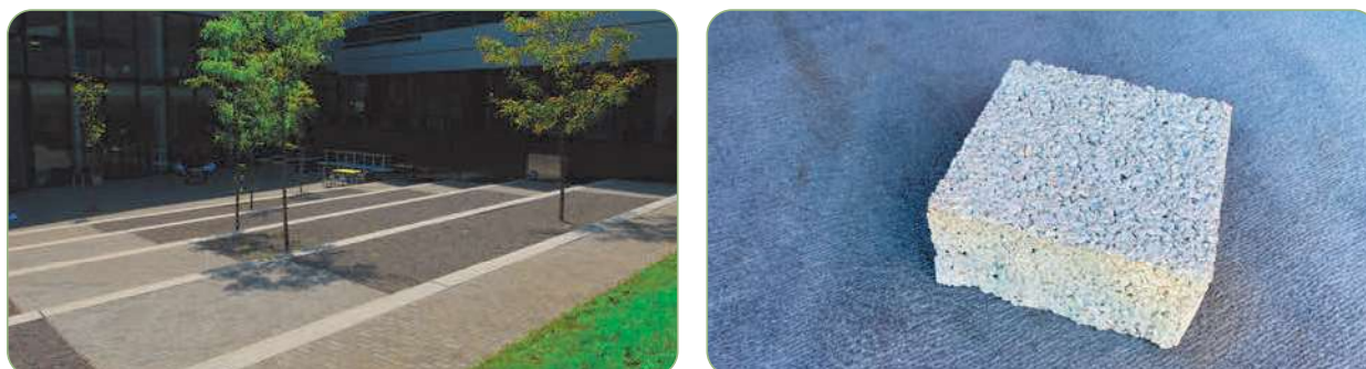
Abbildung 6: Haufwerksporige Betonstein- und Plattensysteme
